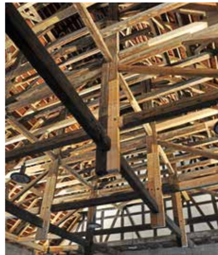
Das Weinbaumuseum Erlenbach erneuert nach der Sanierung seine Ausstellung.
