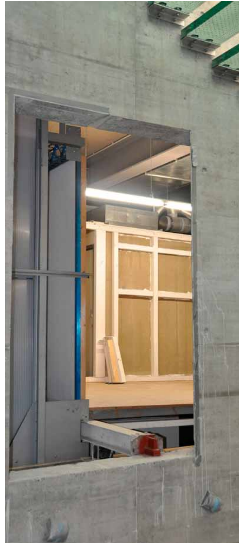
Durchbruch für Barrierefreiheit und Brandschutz im Zeppelin Museum Friedrichshafen.
